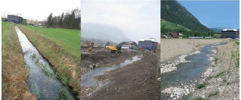
**Bild 3. Abschnitt A vor (links), während (Mitte) und nach (rechts) den Revitalisierungsarbeiten.**
